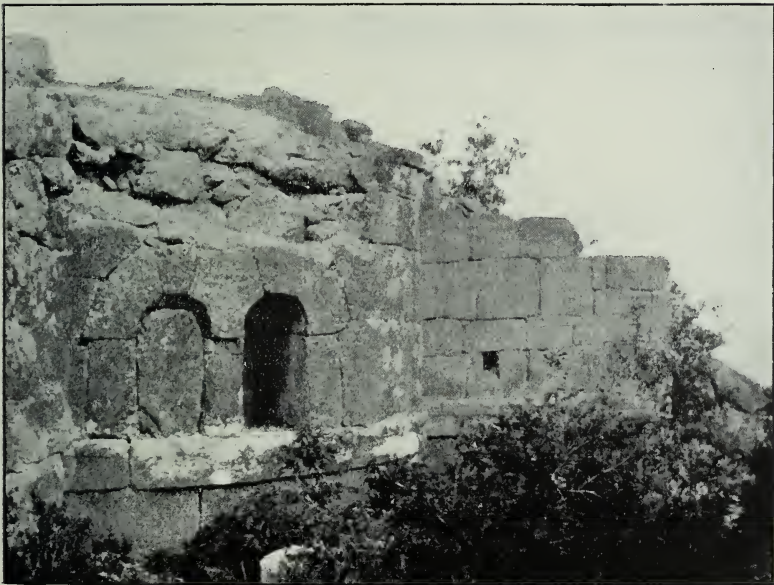
FIG. 221.—Maden Dagh, exterior of apse.
